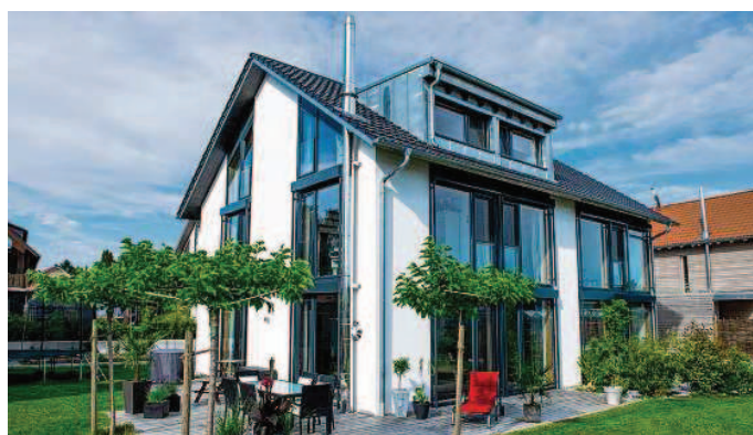
Eine Oase im Grünen: Das Ökohaus von Ibach sorgt das ganze Jahr für ein gutes Raumklima. BILDER: IBACH
