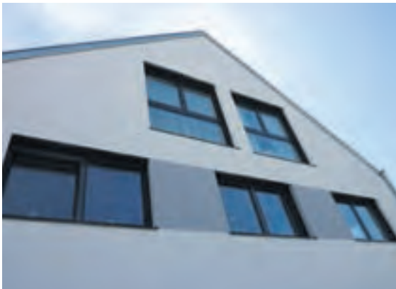
Der gesamte Baukörper wurde in Massivbauweise mit Wärmedämmziegeln im KfW 70 Standard errichtet.
