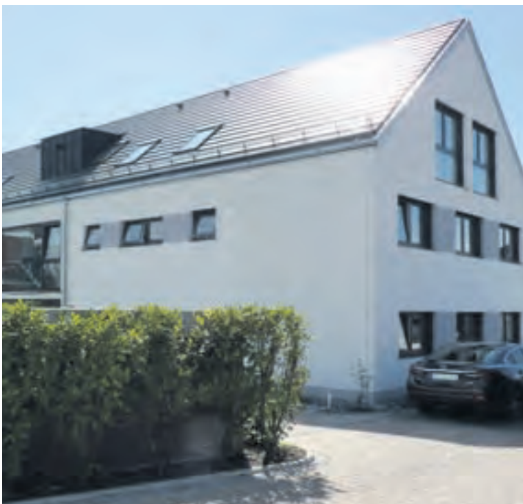
Der gesamte Baukörper wurde in Massivbauweise mit Wärmedämmziegeln im KfW 70 Standard errichtet.
